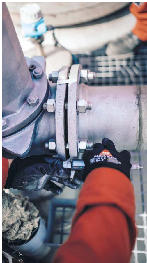
Mit seinem 360-Grad-Ansatz begleitet IDT Anlagenbetreiber im Turnaround vor, während und nach den Revisionsarbeiten.
